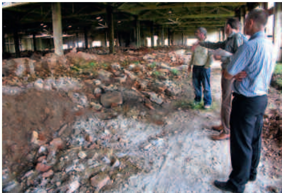
Na het opkuiswerk komt een nieuwe vloer in de eerste hal, dan volgen de tussenwanden voor de eerste business units. (foto: LDS)
